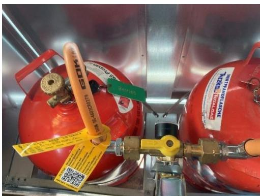
An der bezeichneten Flasche „Betrieb“ den Drehknopf öffnen (nach links entgegen Uhrzeigersinn). Dann gelbes Ventil zwischen den beiden Gasflaschen in Richtung Betriebsflasche drehen. Das Gas strömt in die Leitung ein.
